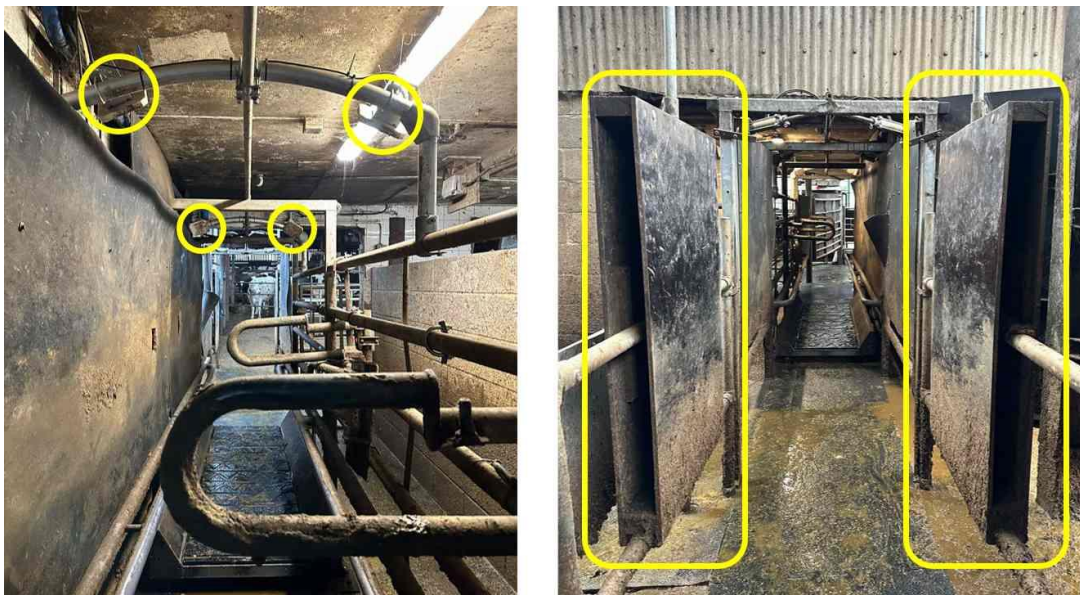
Ffigur 2.3 Gosodwyd y darllenydd UHF sefydlog â phedair antena (ar y chwith, antenau mewn cylch melyn) a phaneli LF electronig HerdVision (ar y dde, o fewn y blychau melyn) ar brif redfa ymadael y parlwr. Mae gwartheg sy'n gadael y parlwr yn mynd heibio i'r antenau UHF ac yna'r system HerdVision. Mae'r llun ar y chwith yn dangos golygfa'r fuwch wrth ymadael, ac mae'r llun ar y dde yn edrych yn ôl i fyny'r rhedfa tuag at y parlwr cylchdro.
