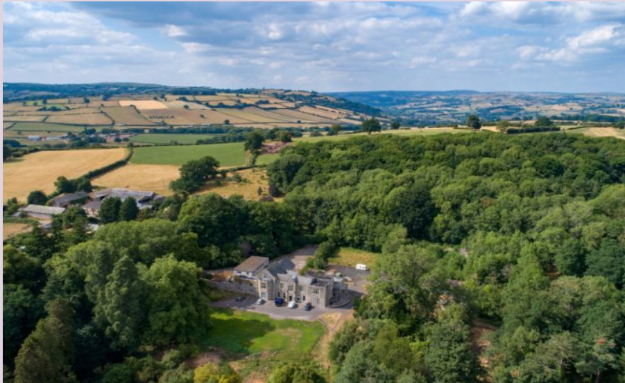
Credyd Delwedd: Hughes Architects
