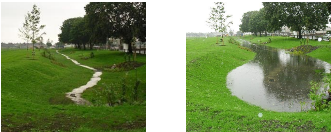
Ffigur 15 – Enghraifft o bant mawr yn ystod tywydd sych (chwith) a storio dŵr yn ystod digwyddiad storm (de), yn ei ryddhau'n araf yn y gwaelod.
