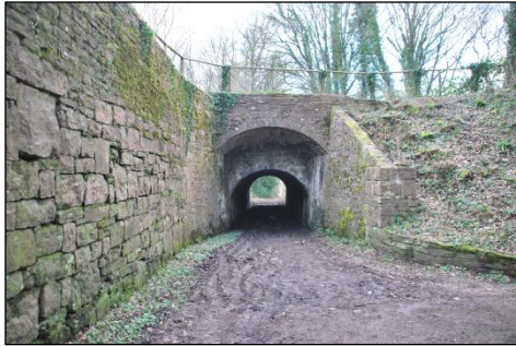
Clydach Railroad passing beneath canal embankment at Gilwern/ Ffordd reilffordd Clydach yn pasio o dan arglawdd y gamlas yng Ngilwern
